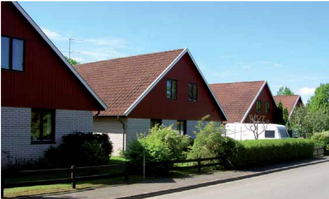
Solskensvägen i Värsås från 1978-1981 hör till de villaområden som bäst ger uttryck för det sena 1970-talets utbyggnad av de mindre tätorterna i Skövde kommun.
