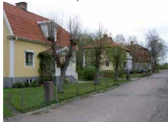
Slingvägen i Tidän med bebyggelse från stationssamhällets storhetstid på 1910-, 20- och 30-talen.
