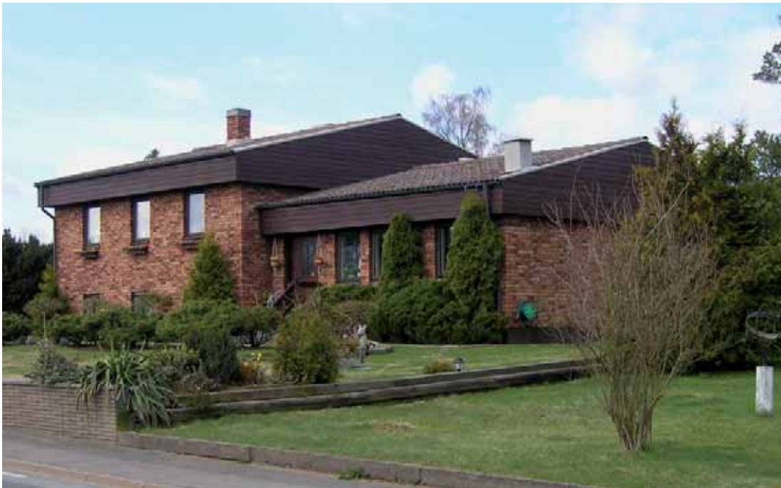
Frösve 3:46. Villan byggdes 1976 i en mer påkostad villastil med fasad i flamrött tegel och mörkbrun panel på takfotssarg och i gavelrösten.
