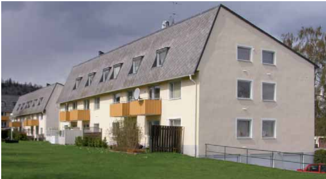
Flerfamiljshusen vid Riksbyggenvägen i Skultorp byggdes i två etapper 1958 och 1960.
